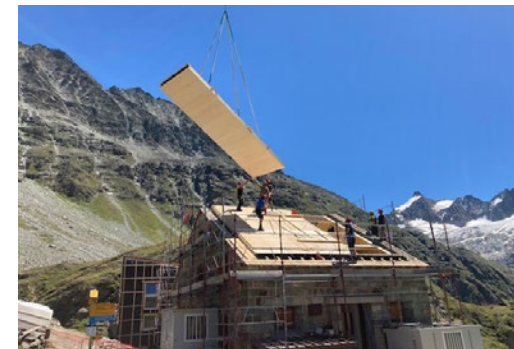
Montage de l'isolation du toit
