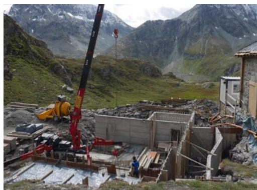
Fondations de l'extension – Septembre 2019
