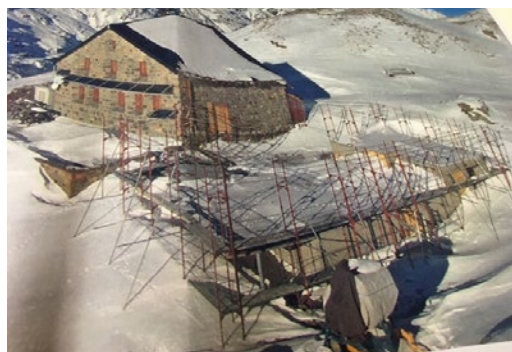
Maçonnerie terminée – Novembre 2019
