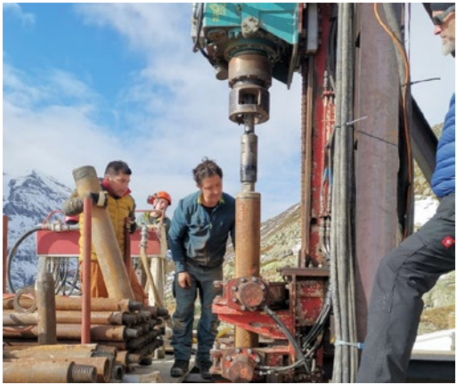
Parcours en fouille dans le terrain
