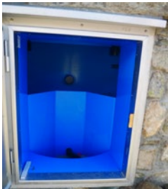
Captage de la source
