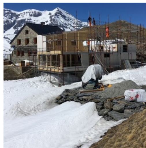
Montage des parois préfabriquées – Printemps 2020
