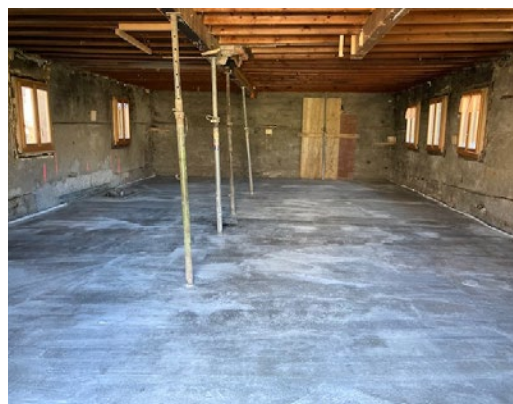
Démolition de l'intérieur de l'ancienne cabane – Printemps 2020
